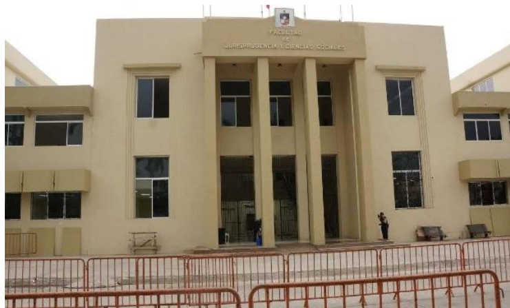
Edificio de la FJCSP
